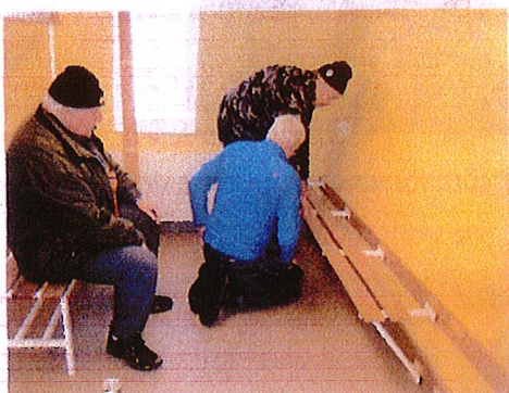
Mats L. övervakar Per-Erik o Mats S. rivning av inredningen.
