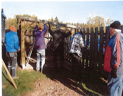
Här påbörjas rivning innan nybygge. Per-Erik, Kent, Peter, Mats S. o Mats L.
